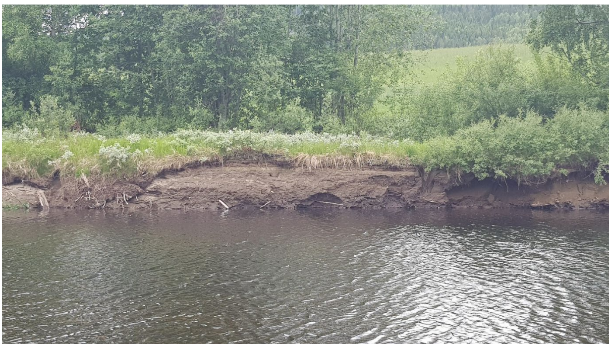
Når en ikke har trær med røtter som armerer kanten, blir elvekantene svært erosjonsutsatt. Foto: Helge. B. Pedersen
