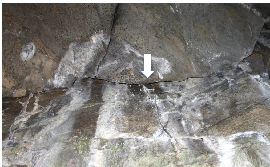
Figur 10: Fuglereir oppunder huletaket
