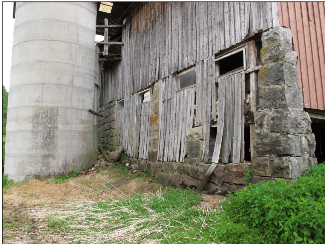
Figur 2. Variert antropogent miljø med støvimpregnerte veggbord, næringsrik natursteinsmur og kalkrik silotank og murfuger.
